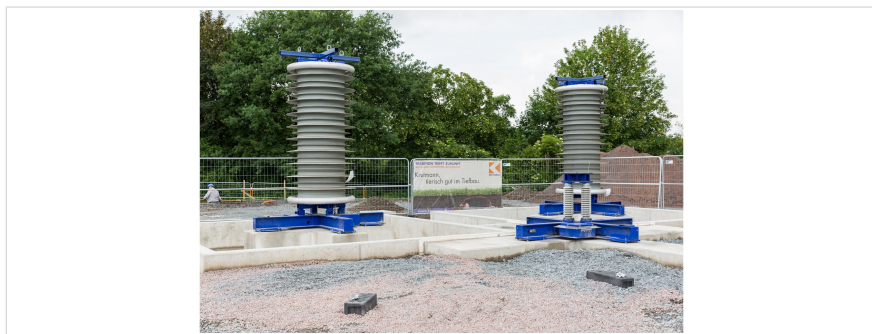
Eine Netzleitung im Aufbau in NRW
