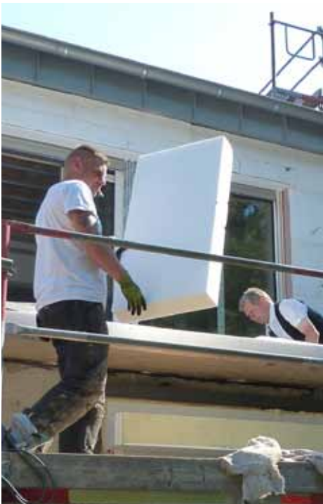
Eine umfassende Isolierung ist der wichtigste Baustein zur Gebäudesanierung, Foto: Tom Jost
