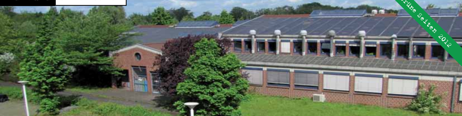
Bochums älteste Solaranlage auf dem Dach der Laboratorien Dr. Wessling hat inzwischen einige Fehler, produziert aber immer noch eine ansehnliche Menge emissionsfreien Strom, Foto: Tom Jost
