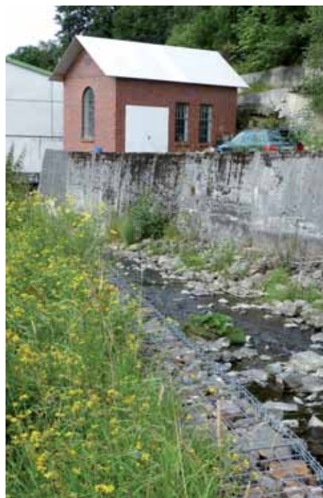
Die Stromerzeugung an Gewässern – hier in Brilon-Wald – wird zunehmend schwieriger, Foto: Tom Jost
